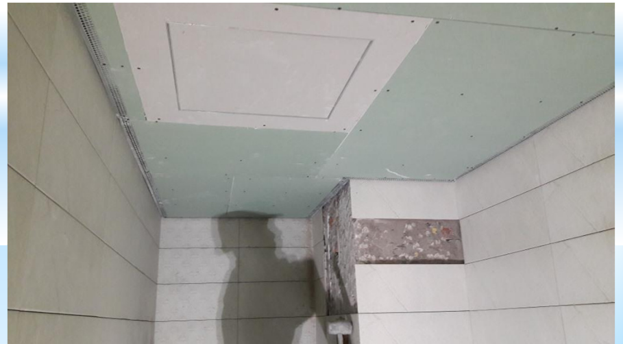
HẬU QUẢ: Gạch bề mặt, trầy xước đục thay lại
